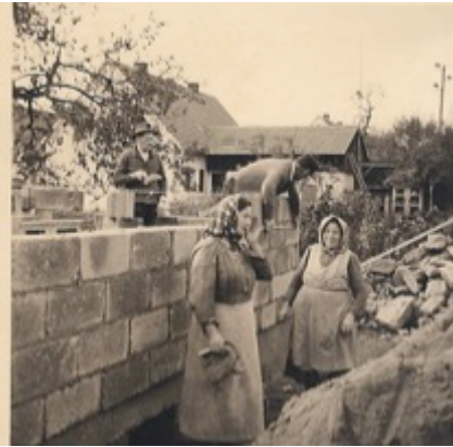
1955: Hausbau in Daisbach 17
